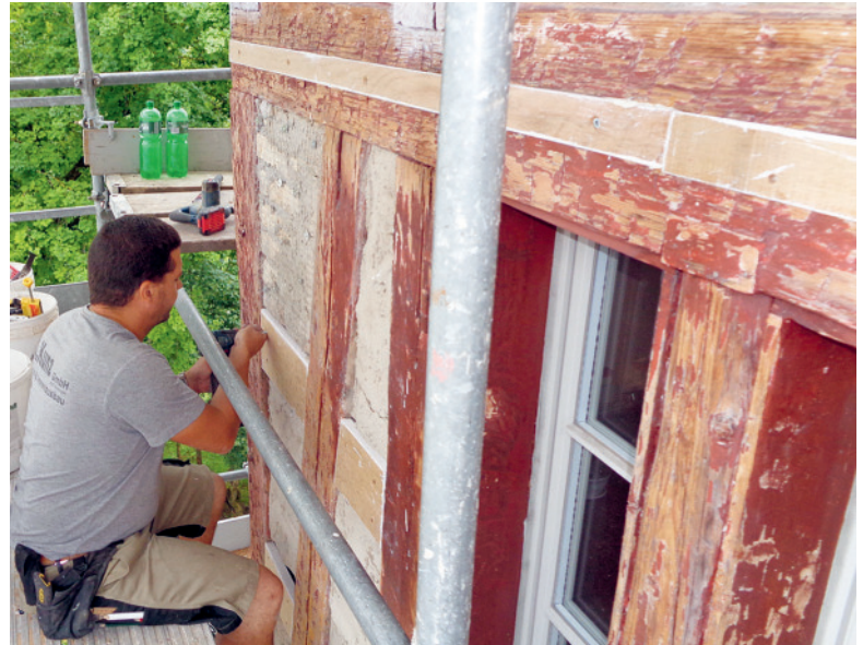
Holzfachmann Andi Kunz am Werk. Die alten Holzbalken waren in einem schlechten Zustand und mussten teilweise ersetzt werden. Bild: Ueli Lüthi
