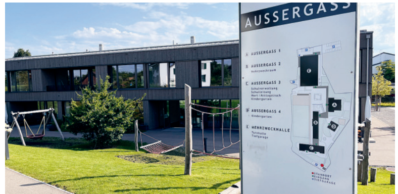
Schon im Sommer 2023 soll das aufgestockte Schulhaus bereit sein. Bild: MG
