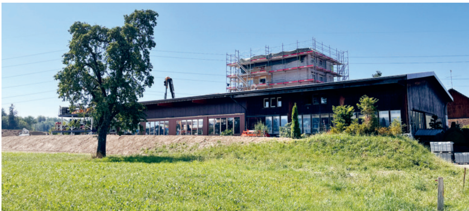
Das Betriebsgebäude wird vergrössert, der Büroturm verbreitert. Bild: Martina Gradmann
