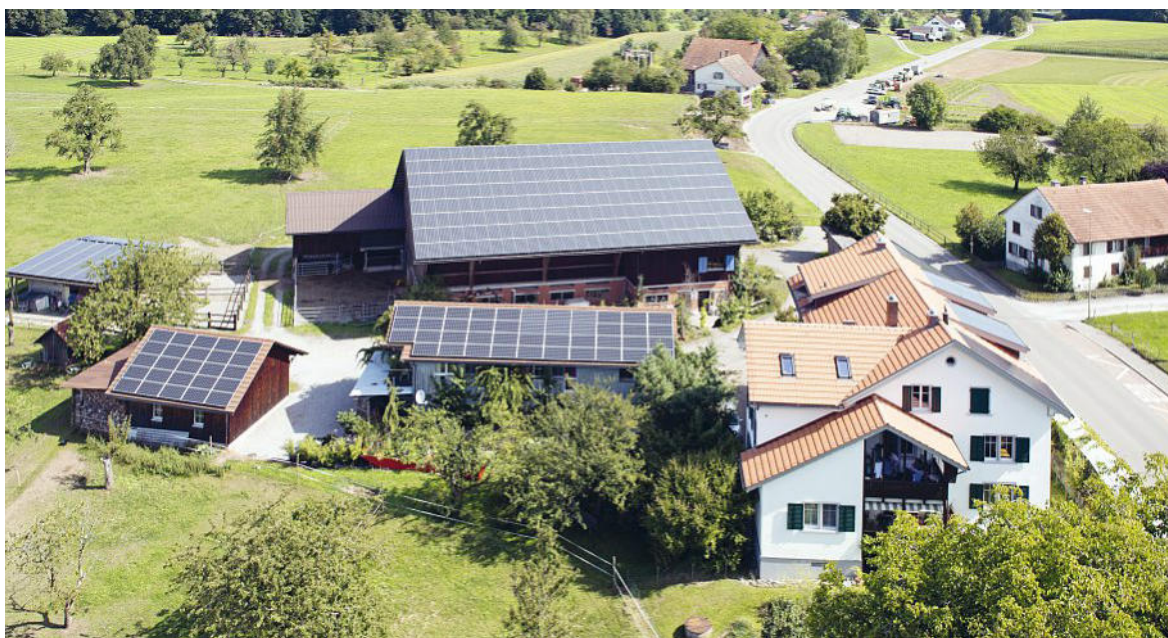
In Grüningen werden vermehrt Photovoltaikanlagen auf die Dächer gebaut.
