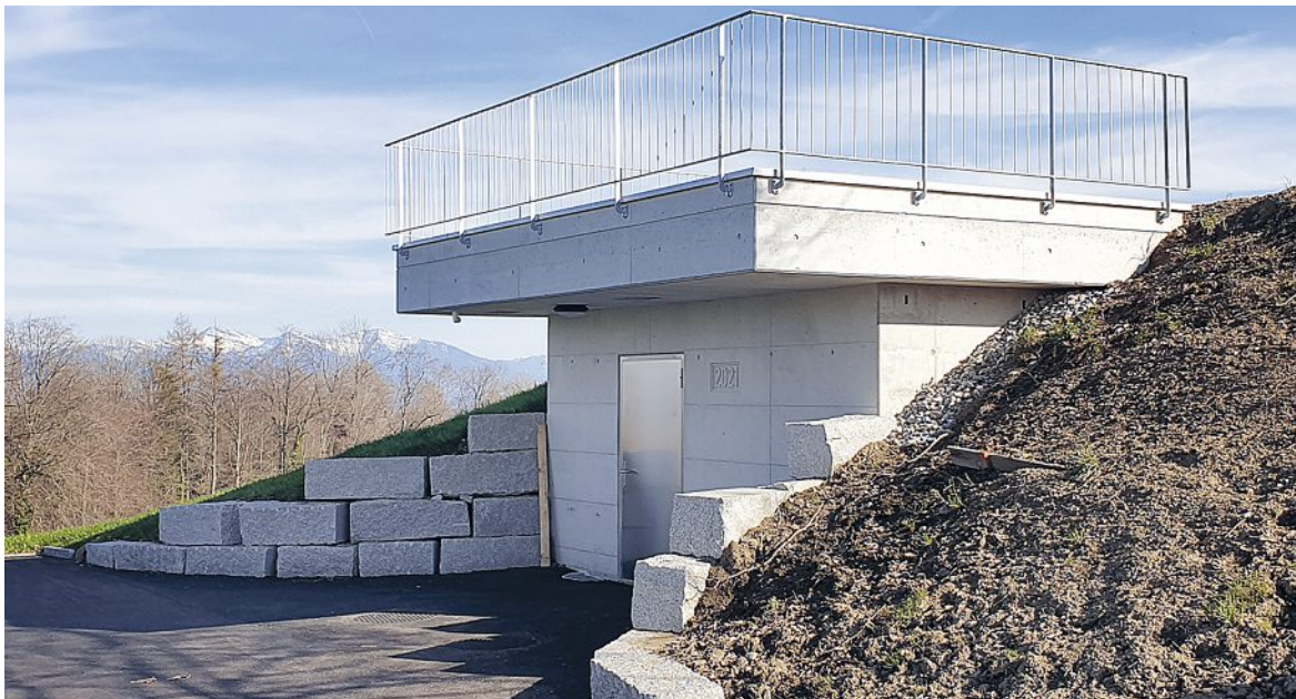
Die Wasserversorgung Rebrain kann am 6. Mai 2023 besichtigt werden.
