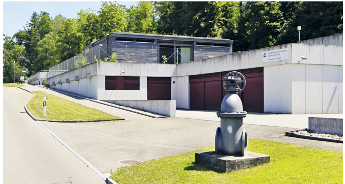
Die Filteranlage Mühleholzli oberhalb von Stäfa. (Archivbild)
