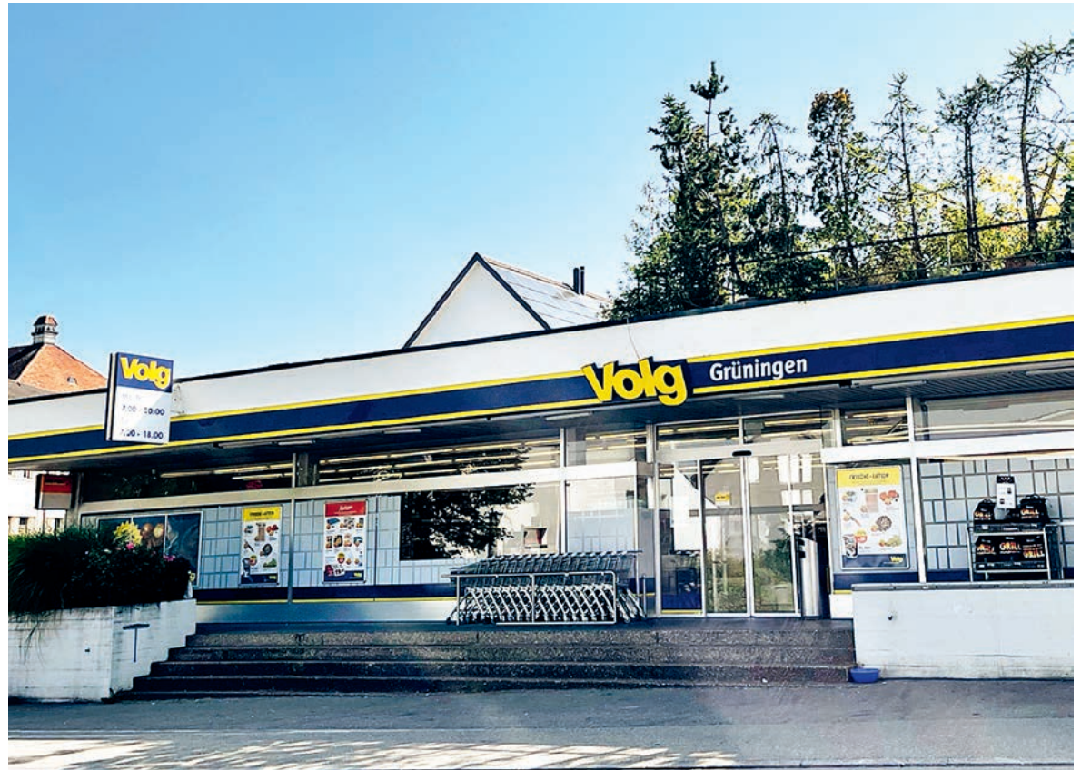
Erstrahlt bald in neuem Glanz: der Volg an der Binziker-Strasse.
