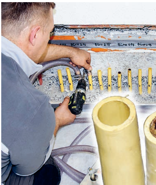
Die Rohre der Bodenheizung werden gespült und schonend gereinigt.
