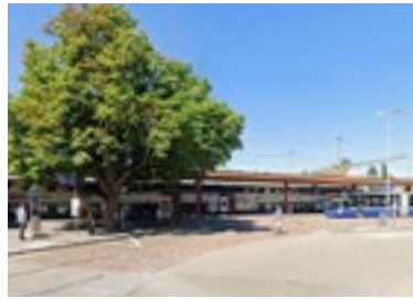
Der Bushof am Bahnhof Wetzikon wird saniert. Archivbild: Google Street View
