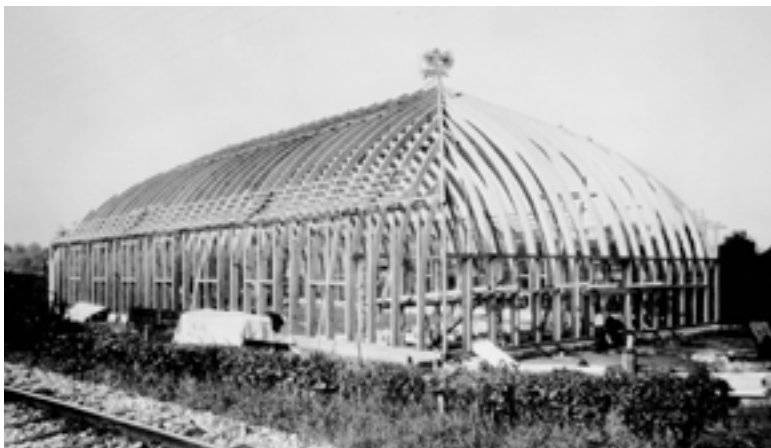
Die Reithalle Wetzikon im Bau, 1927.
