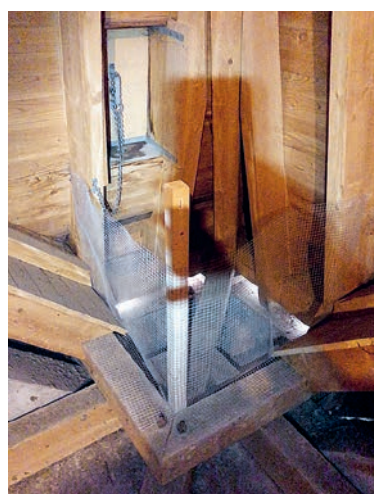
Abb. 2: Konstruktion aus Drahtgeflecht.
