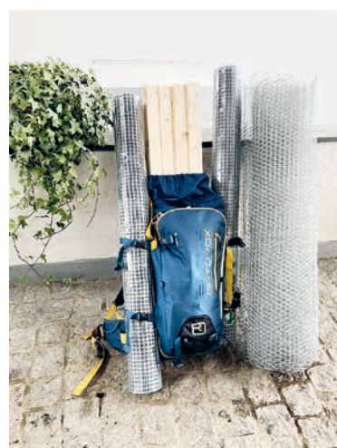
Abb. 3: Der Materialtransport hinauf zum Kirchturm war eine Herausforderung.
