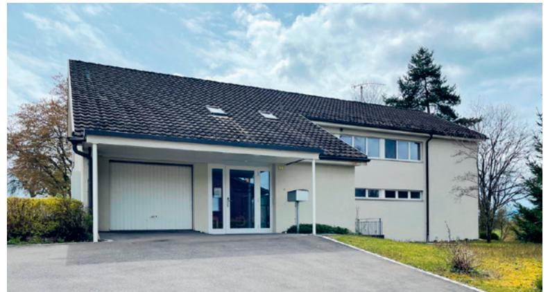
Der Betrieb des Kindergartens Silberberg I wird ab Sommer 2024 wieder aufgenommen. (Archivbild)
