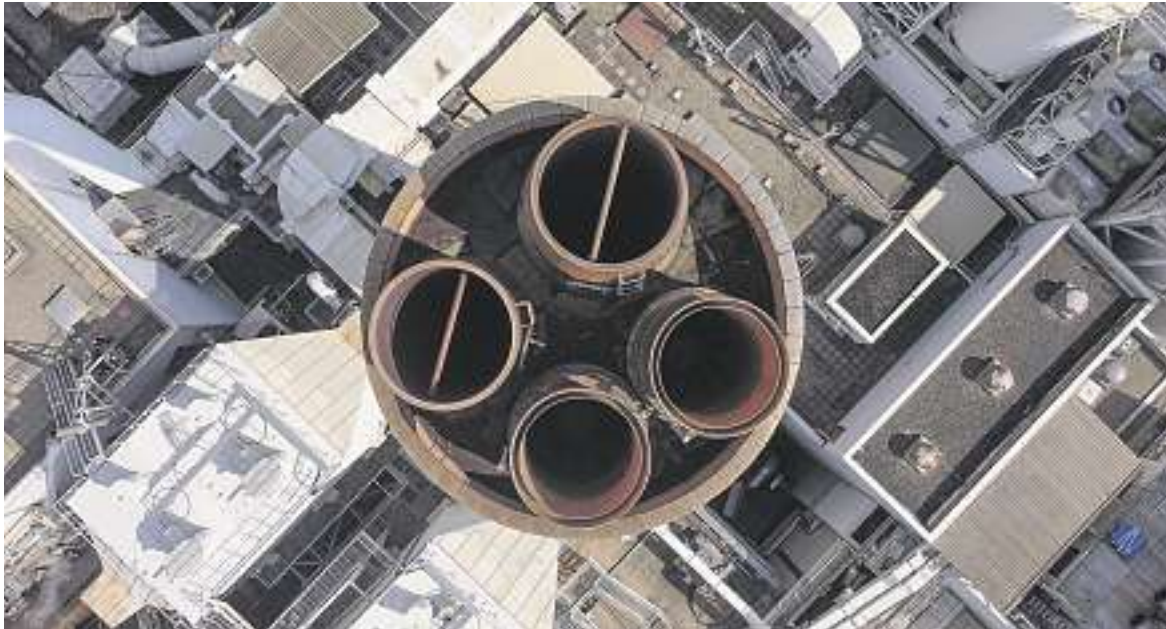
Aufnahme im Rahmen von Vermessungsarbeiten (Photogrammetrie) bei der Kezo in Hinwil.
