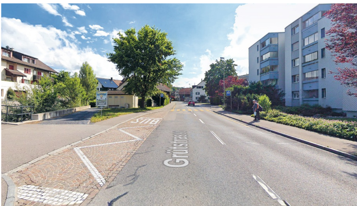
Die Bauarbeiten an der Grütstrasse werden 18 Monate dauern.
