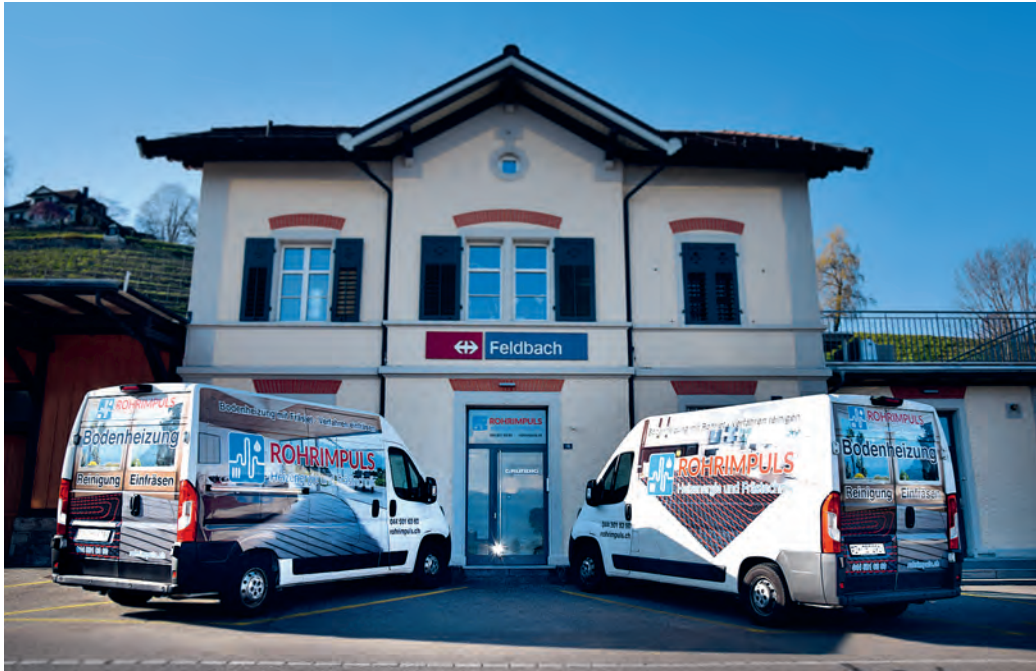
Die Rohrimpuls GmbH befindet sich direkt im Bahnhofsgelände in Feldbach.
