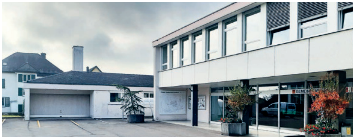
Die Abbrucharbeiten werden voraussichtlich im April 2024 beginnen.
