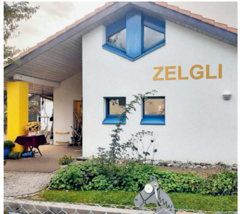
Der Kindergarten Zelgli hat eine PV-Anlage.
