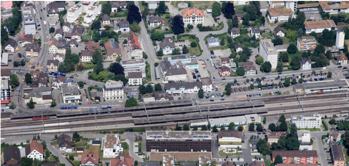
Das Areal beim Bahnhof Unterwetzikon soll neu gestaltet und für die Zukunft gerüstet sein.
