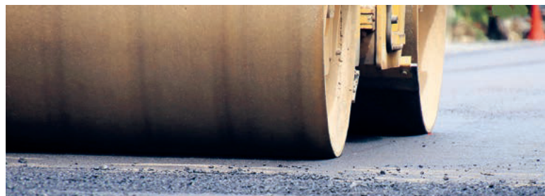
Die 2. und die 3. Etappe der Bauarbeiten haben begonnen. (Symbolbild)
