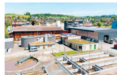
Die ARA Gossau könnte von einem Grundwasser-Wärmeverbund profitieren. (Archivbild)
