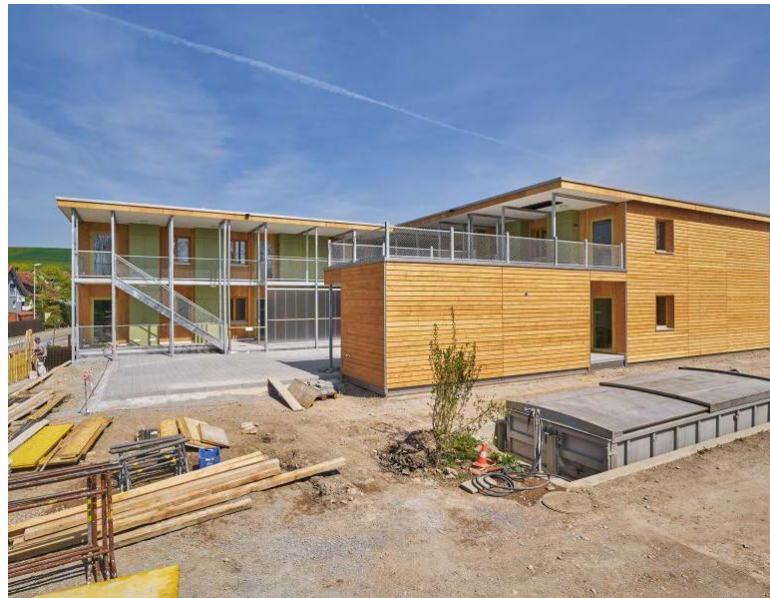
Die Temporäre Wohnsiedlung Rössliwiese in Unter-Ottikon soll erweitert werden. (Archivbild)
